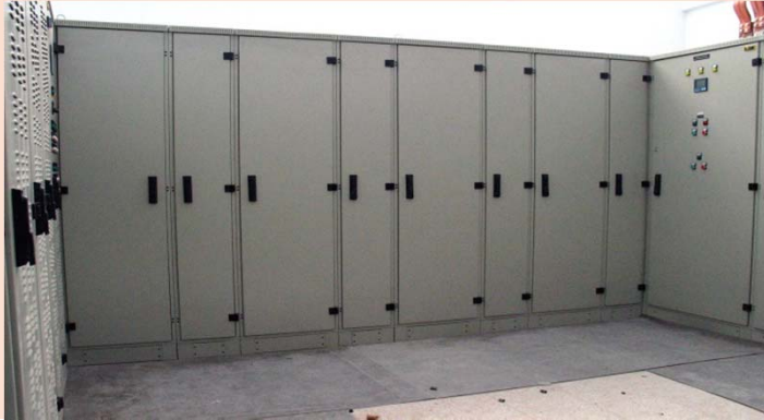
Devreye Alınmış 400V Alçak Gerilim Panellerimiz. Our Commissioned 400V Low Voltage Panels.
