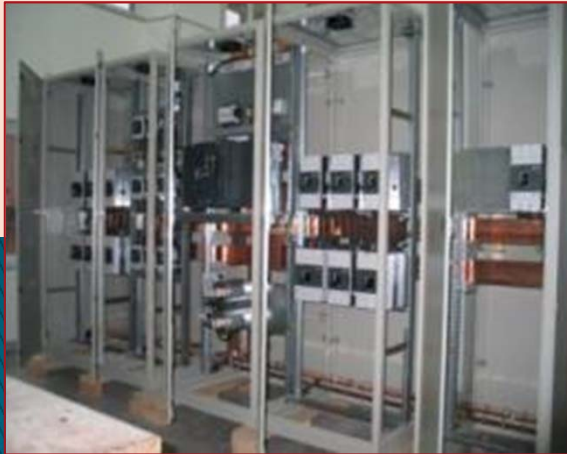
Siemens Orta Gerilim Hücreleri Kabul Test Çalışması Siemens Medium Voltage Switchgears Acceptance Test Study.
